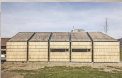
Schindelhülle mit Fensterbändern
