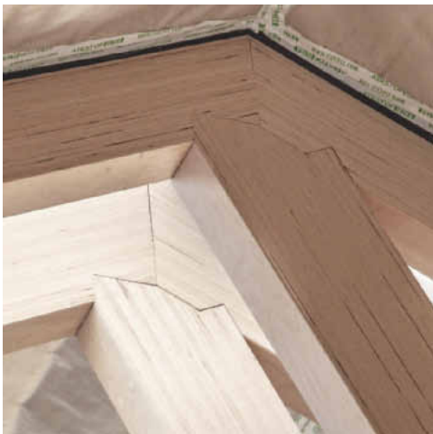
Hohe Handwerkskunst: Stoßverbindungen mit ungewohnter Formgebung
