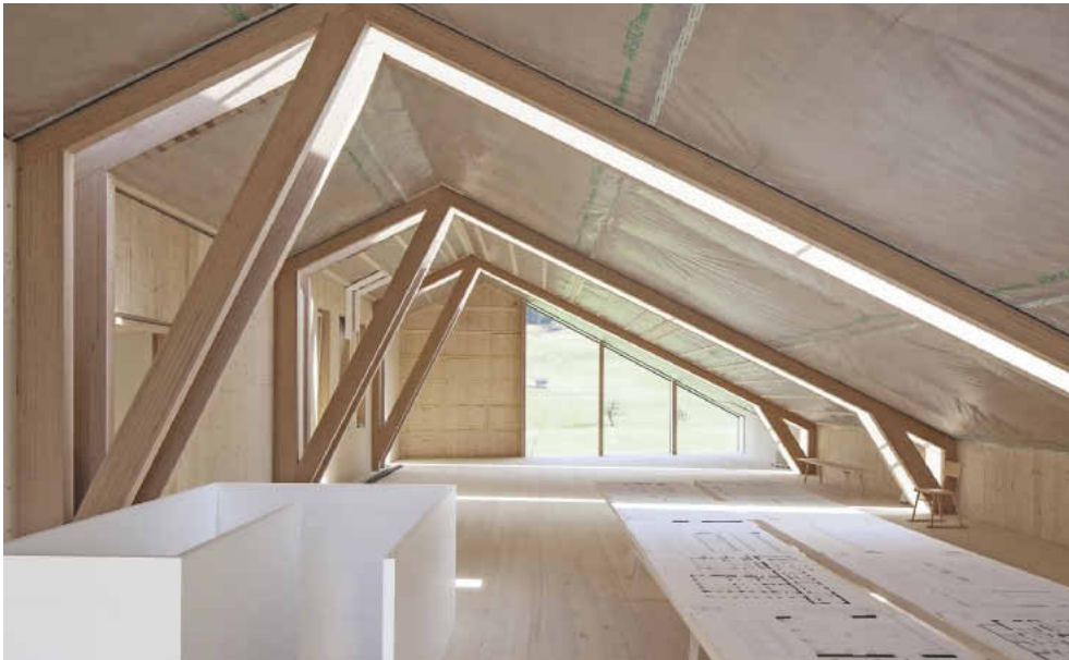
Besonders filigrane Dachkonstruktion mit BauBuche von Pollmeier
