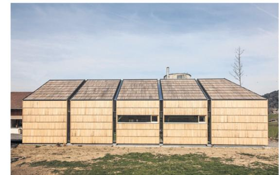
**Öffnen** Beide Giebelseiten sind großzügig verglast. Das schafft optimale Lichtverhältnisse. Der Betrieb bleibt zudem in Verbindung mit dem Dorf. Eine Besonderheit sind die großen Schindeln an Dach und Wand.
